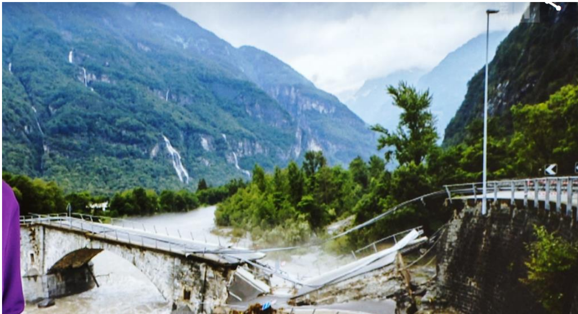
Zerstörte Brücke bei Celio.
